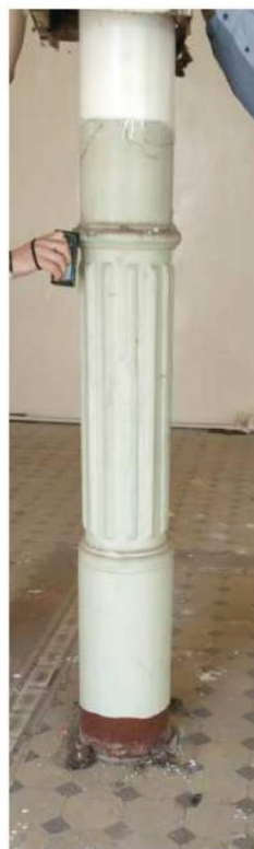
Чугунная колонна опирания сводов "Монье" третьего этажа. Помещение по главному фасаду.
