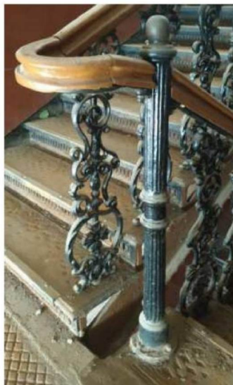
Парадная металлическая лестница по правому флангу. Ажурные чугунные балясины. Каннелюрованные столбики промежуточной площадки.
