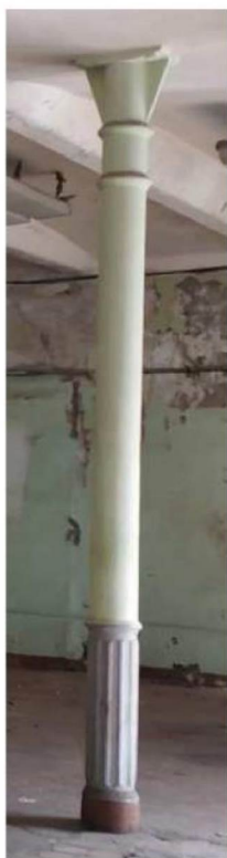
Чугунная колонна опирания сводов "Монье" второго этажа. Помещение по главному фасаду.
