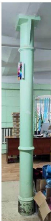
Чугунная колонна опирания сводов "Монье" первого этажа. Помещение по главному фасаду.
