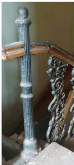
Парадная металлическая лестница по левому флангу. Ажурные чугунные балясины. Каннелюрованный столбик площадки второго этажа.
