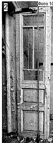
Тип 2. Высота полотна 290 см. Ширина дверей 155 см. Ширина полотна 76 см.
