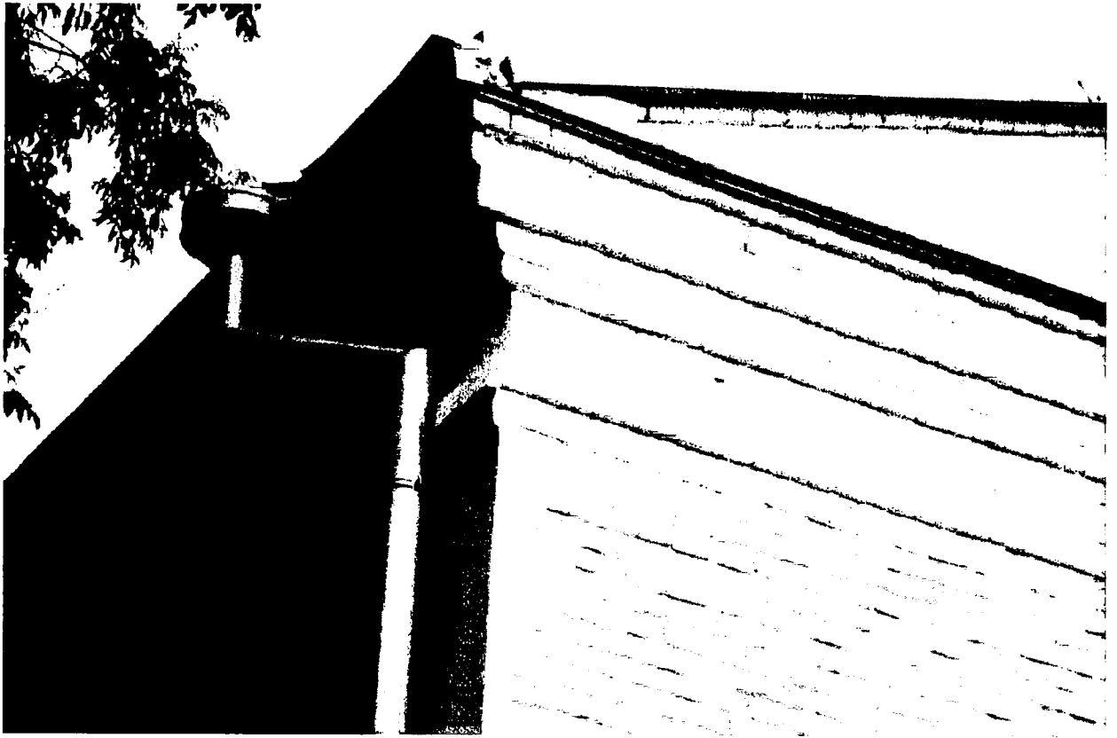
Фото 16. Антаблемент на северо-западном углу здания.
