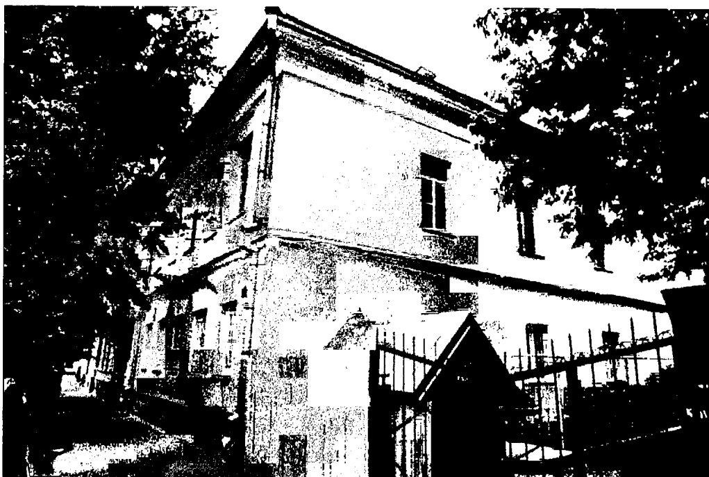
Фото 1. Вид здания с юго-востока. На ближнем плане – объем 1-й половины XIX в.
