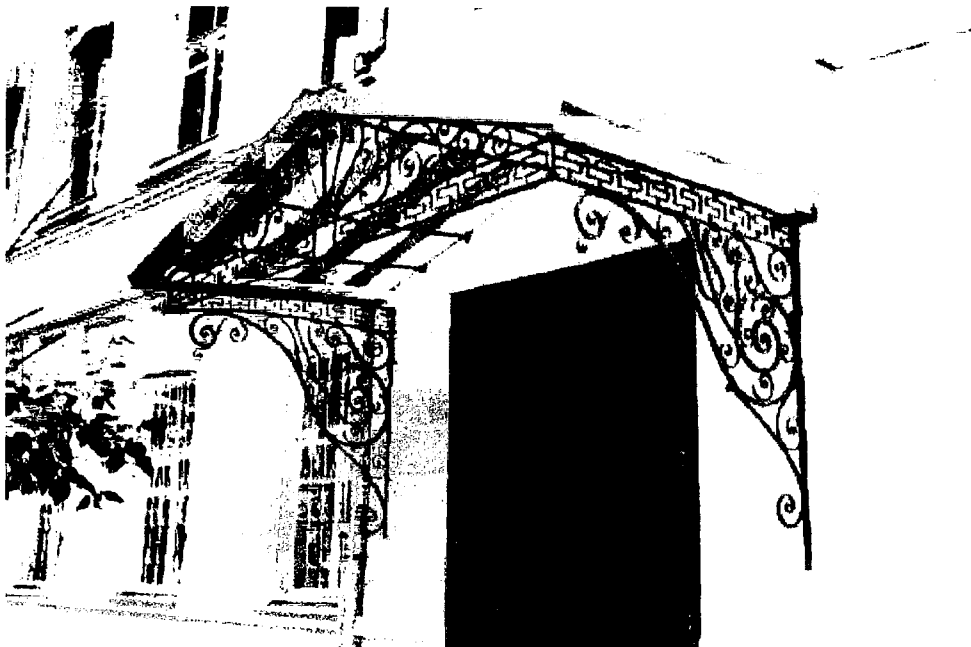
Фото 11. Козырек главного входа.
