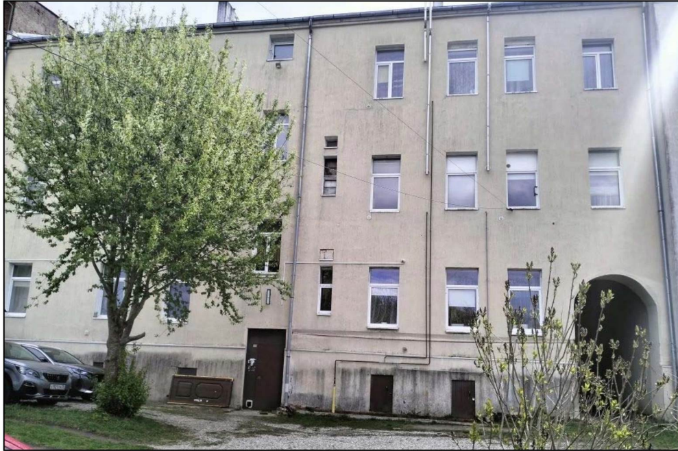
Фото 2. Северо-западный фасад дома № 43.
