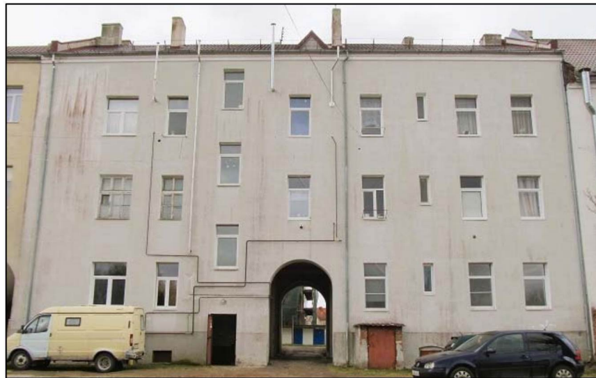
Фото 3. Северо-западный фасад дома № 41
