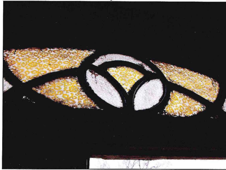
Фото 9. Фрагмент остекления фрамуг оконных проемов лестничной клетки.
