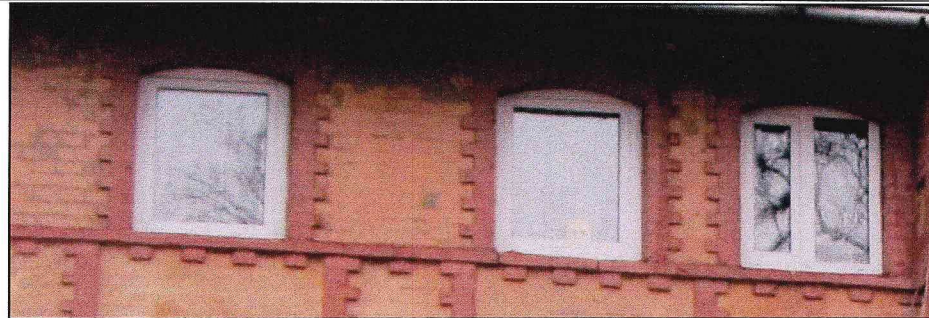
Фото 6. Вид оконных проемов третьего этажа и чердака.
