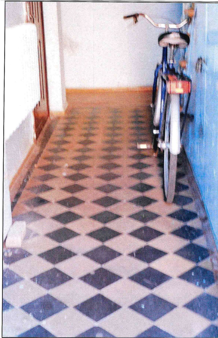
Фото 3. Напольное покрытие из метлахской плитки.
