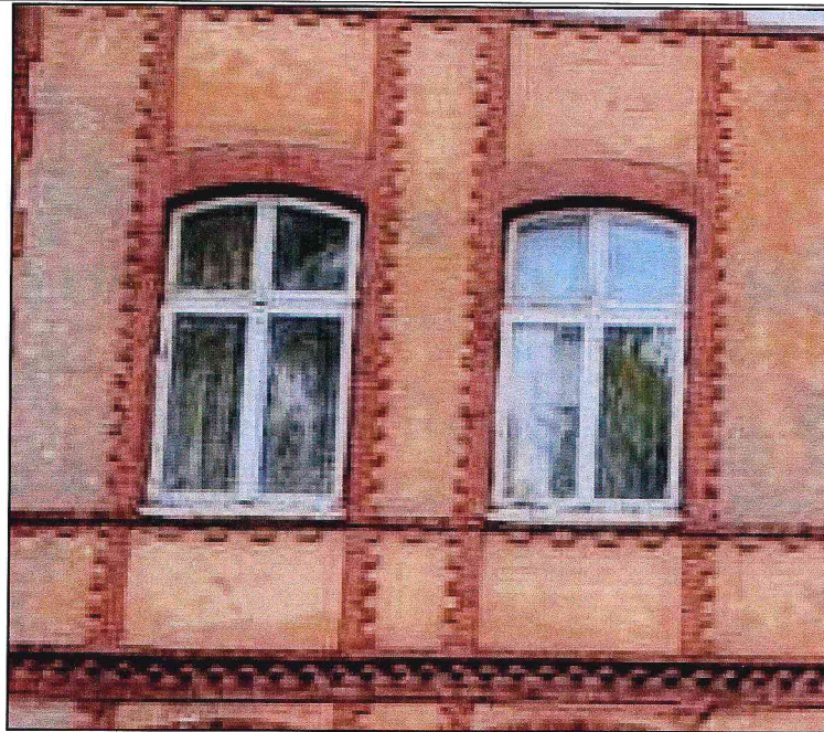
Фото 8. Декоративное оформление оконных проемов с лучковыми перемычками первого, второго этажей.
