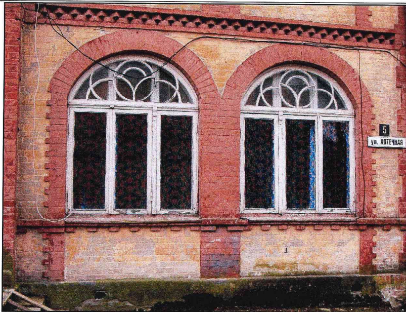
Фото 3. Вид оконных проемов на северном фасаде.
