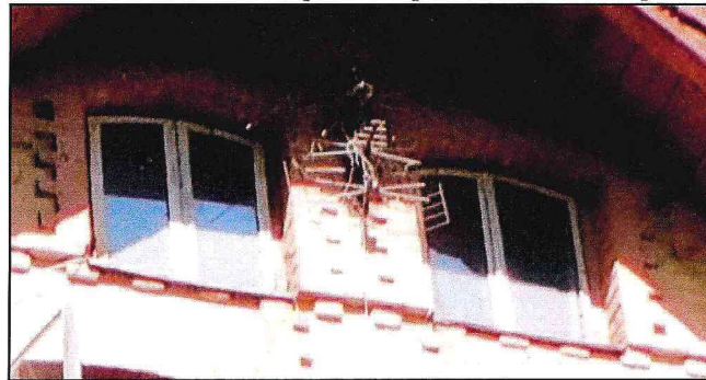
Фото 7. Вид оконных проемов чердака ризалита южного фасада.
