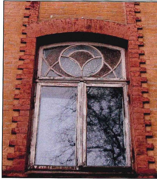
Фото 8. Вид оконных проемов лестничной клетки.
