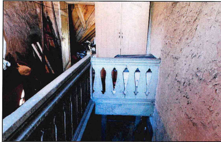
Фото 2. Ограждение лестничной площадки в уровне чердака.
