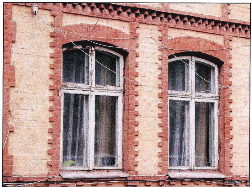
Фото 4. Вид Оконных проемов с форточками.
