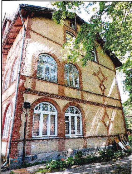
Фото 6. Западный фасад Памятника.
