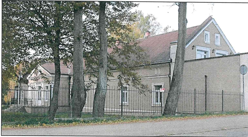
Вид с юго-востока, южный и восточный фасады Памятника.
