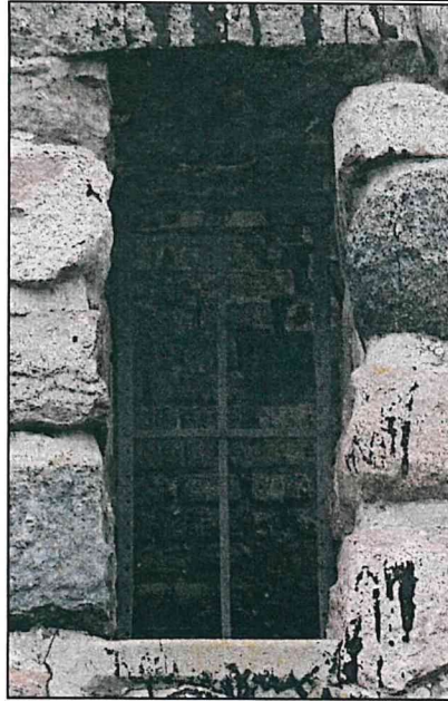
Фото 6. Оконный проем восточного фасада на втором-третьем уровнях.
