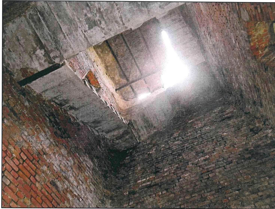
Фото 4. Общий вид межуровневой лестницы.
