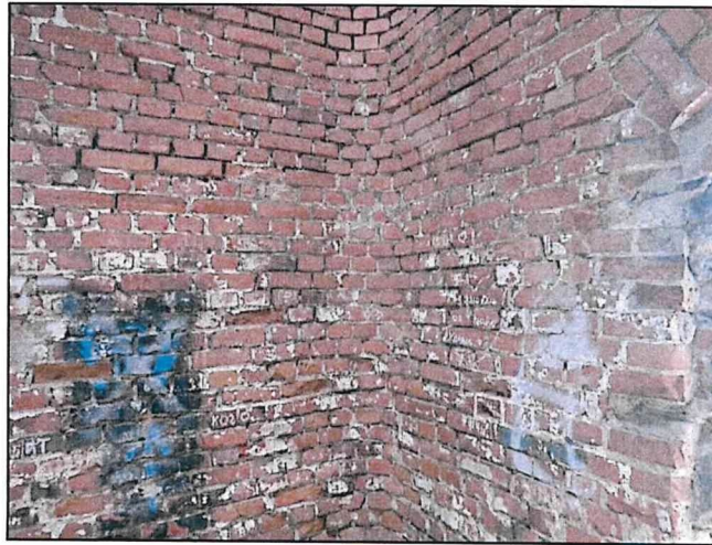
Фото 2. Вид кирпичной кладки внутренних стен Памятника.
