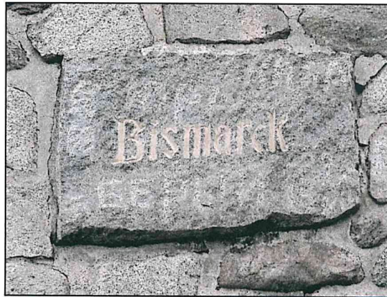
Фото 1а. Вид закладного камня.
