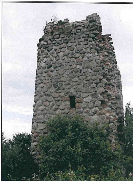
Фото 4. Северный фасад Памятника.
