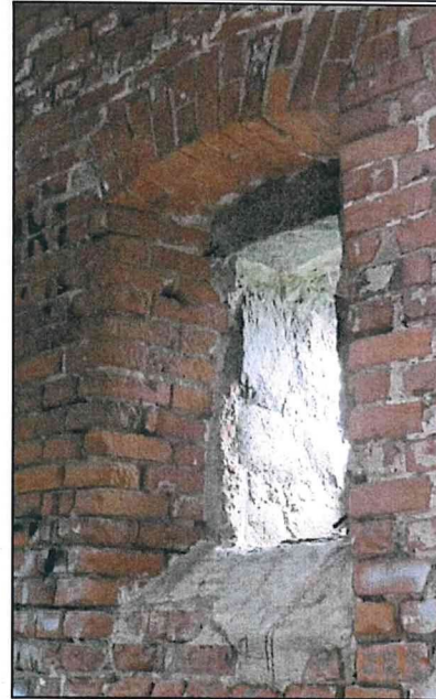
Фото 7. Вид оконных проемов изнутри.
