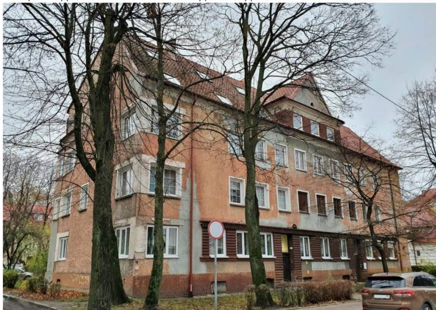
Фото 2. Общий вид Памятника с северо-востока. Западный главный и северный боковой фасады.
