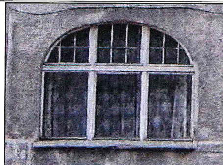
Фото 6а (2006 г.) Заполнения оконных проемов.
