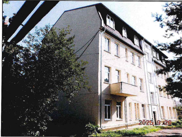
Фото 6. Западный дворовый фасад Памятника. Вид с северо-запада.
