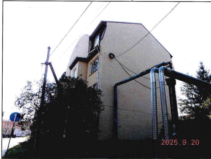
Фото 5. Вид на северный боковой фасад Памятника.
