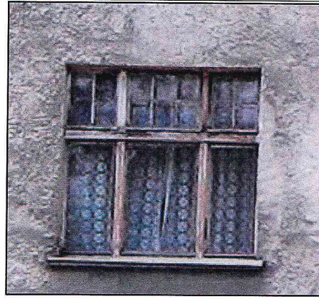
Фото 7а (2006 г.) Заполнения оконных проемов.
