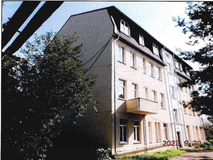
Фото 2. Общий вид Памятника с северо-запада Северный боковой и западный дворовый фасады.
