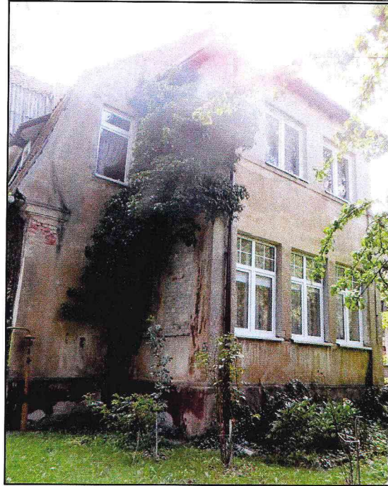
Вид с северо-запада, западный фасад Памятника.
