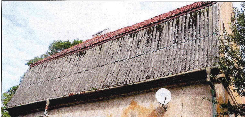
Фото 11. Южный скат крыши.
