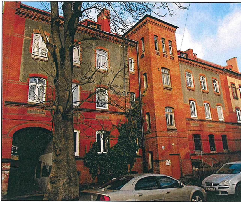
Фото 2. Вид с юго-запада, южный фасад.
