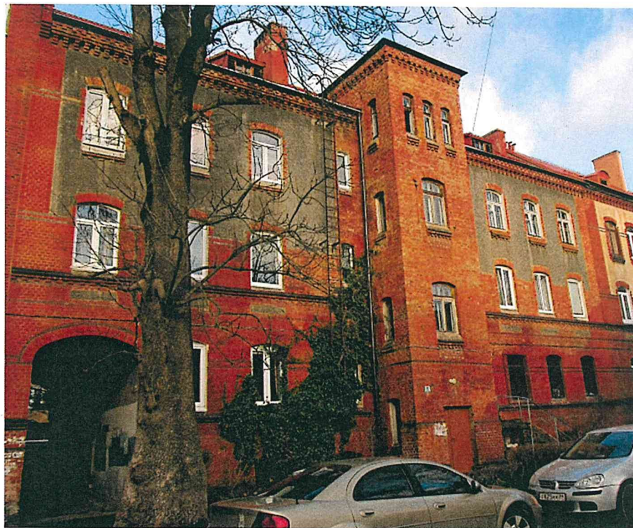
Фото 2. Вид с юго-запада, южный фасад.
