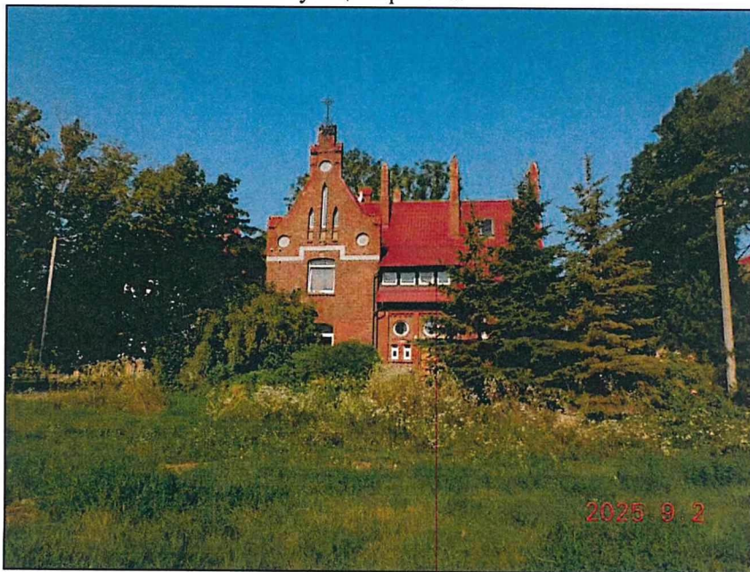
Фото 1. Общий вид на Памятник с юго-востока.
