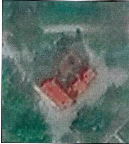
Фото 15. Общий вид крыши сверху.
