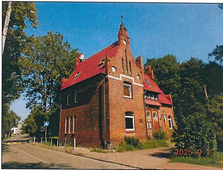
Общий вид Памятника с юга. Юго-восточный главный и юго-западный боковой фасады (фасады № 1, № 4).
