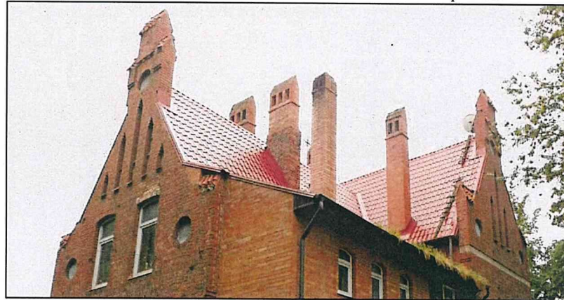
Фото 14. Вид с севера. Северо-западный скат крыши.
