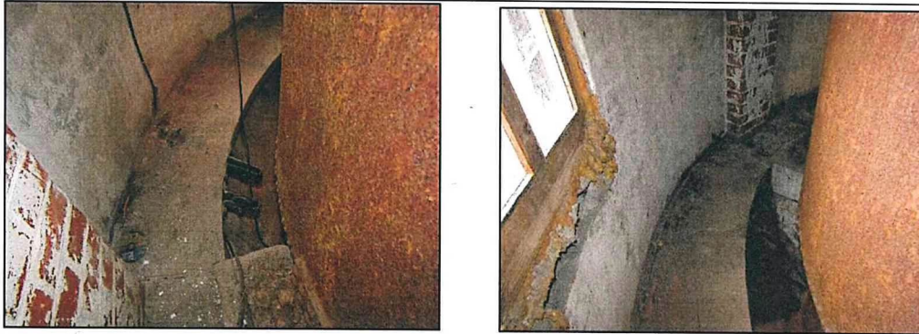
Фото 7. Вид конструкции башни в уровне шестого яруса.
