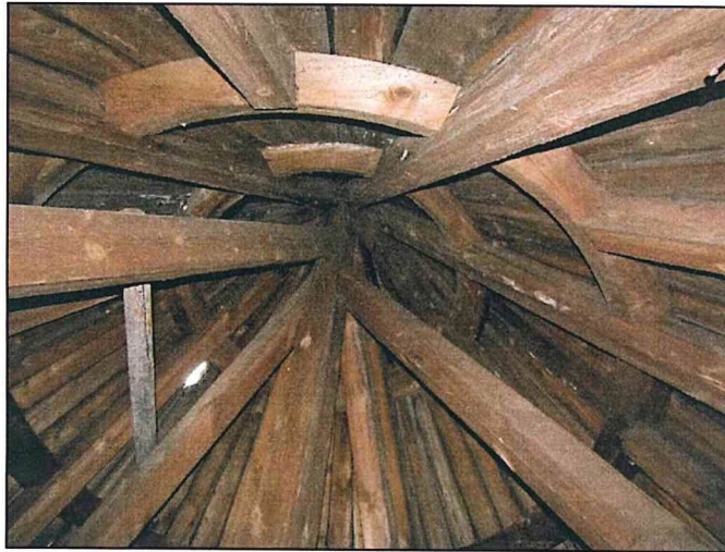
Фото 12. Вид деревянных конструкций крыши.
