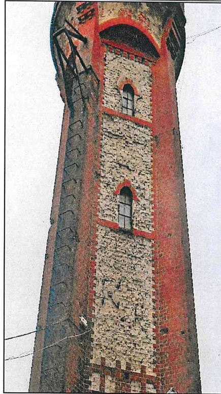
Фото 3а. Вид металлических скоб-ступеней на восточном бафасаде башни.
