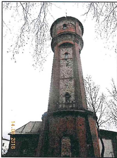
Фото 5. Северный фасад башни, северный фасад пристройки.
