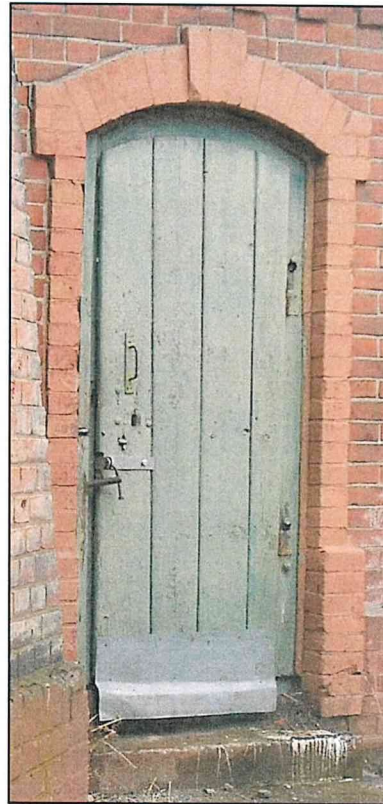
Фото 18. Дверной проем на южном фасаде пристройки.
