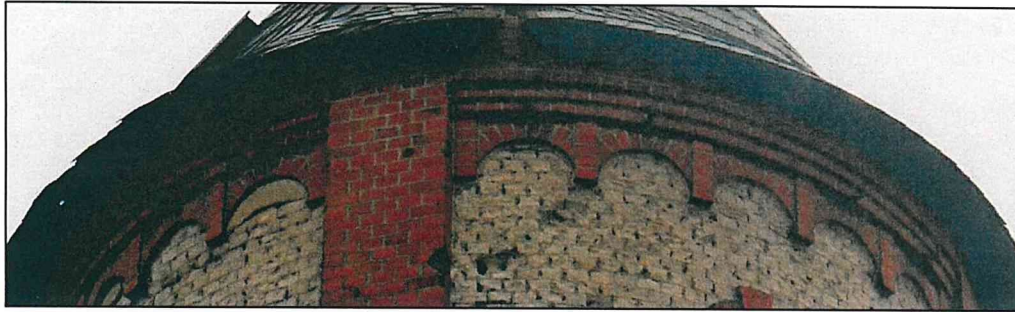
Фото 5. Венчающий карниз с фризом.
