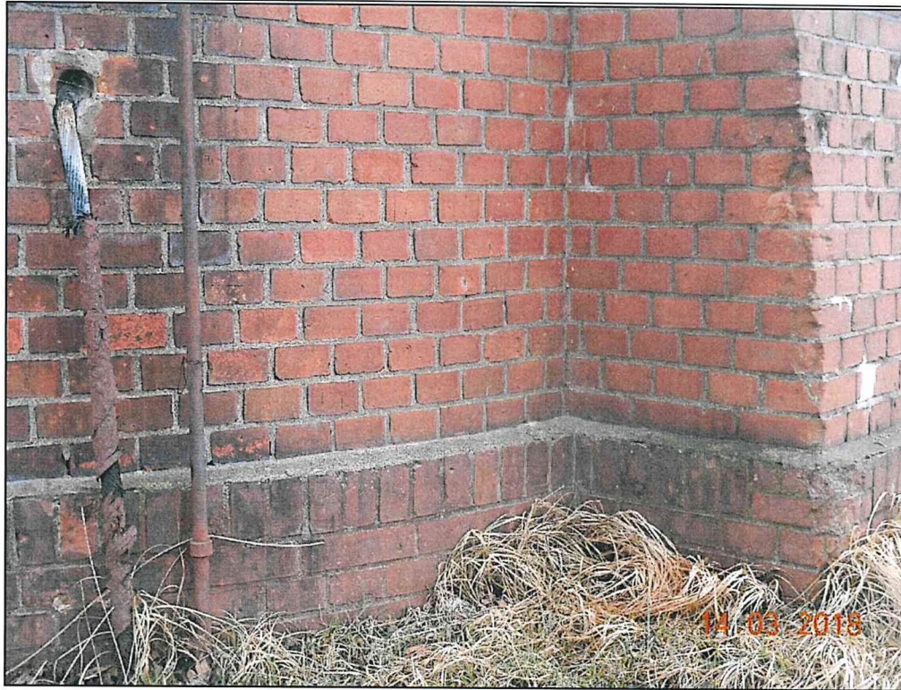
Фото 9. Конструкция цоколей башни.
