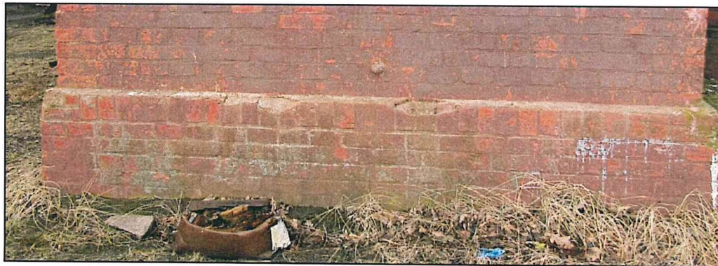
Фото 10. Конструкция цоколей пристройки.
