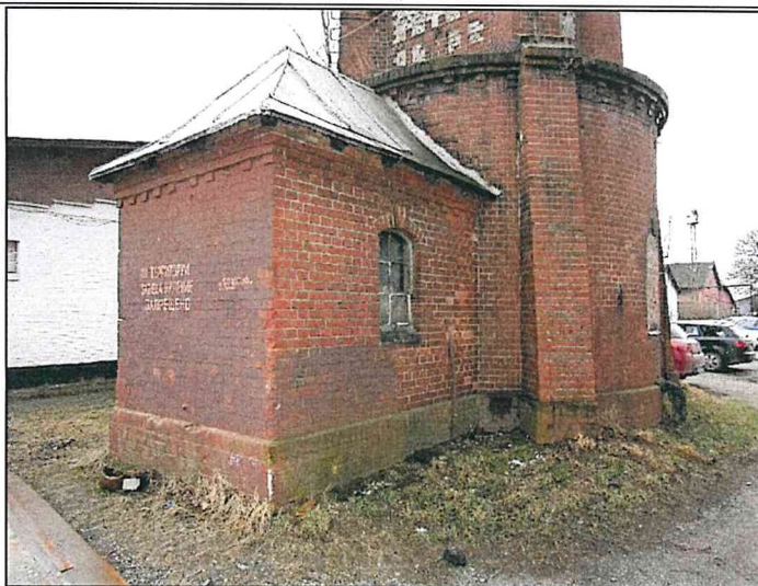
Фото 7. Вид пристройки с северо-востока. Северный и восточный фасады.
