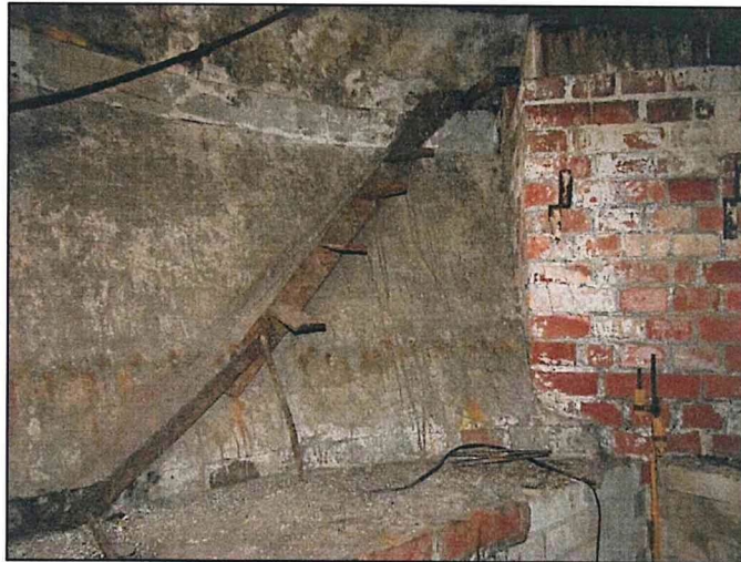
Фото 6. Вид внутренней конструкции пятого яруса.
