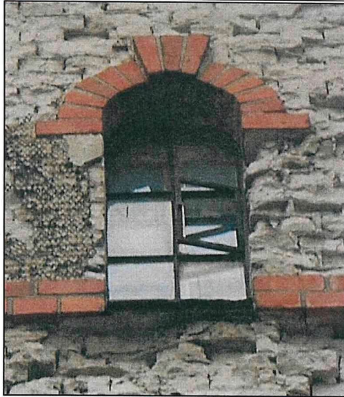
Фото 15. Оконные проемы в уровне шестого яруса.
