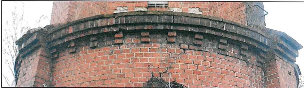
Фото 6. Венчающий карниз с фризом.
