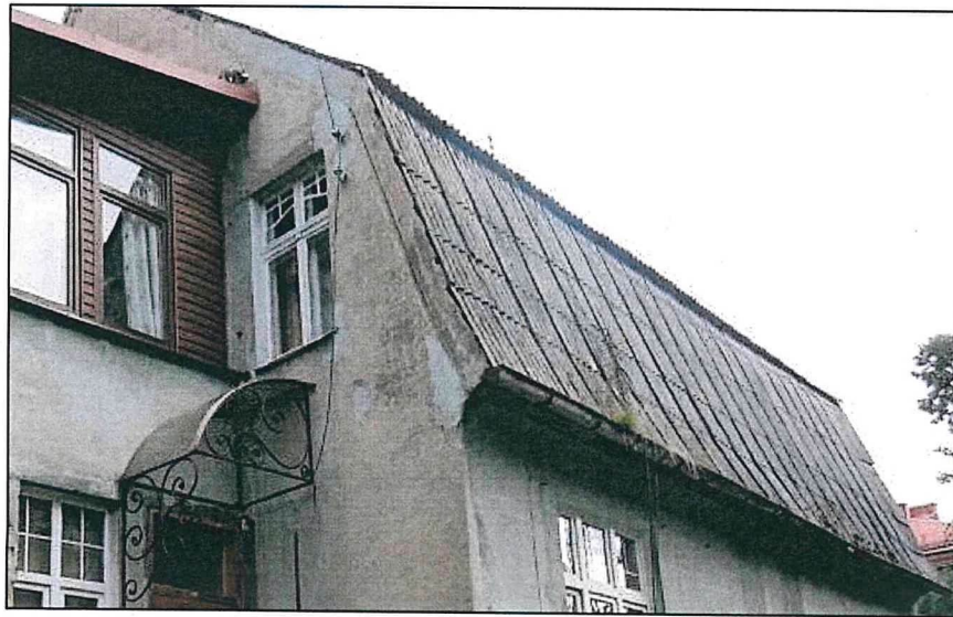
Фото 12. Южный скат крыши.
