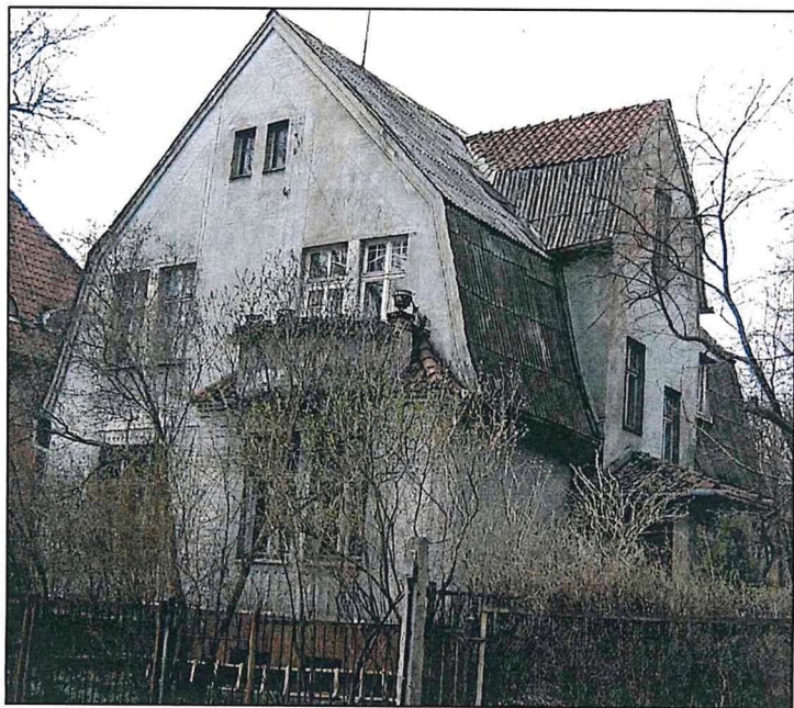
Вид с северо-востока, северный и восточный фасады Памятника.
