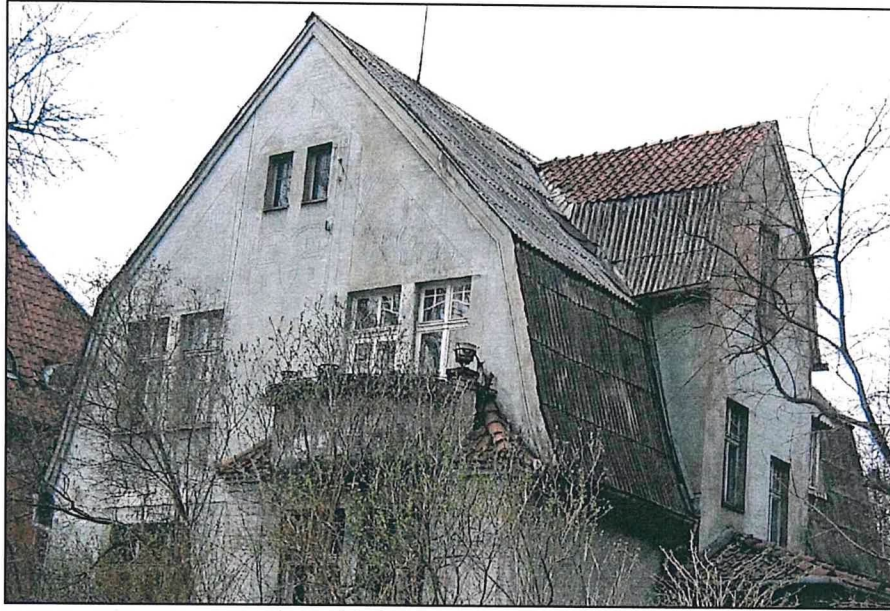
Фото 11. Северный скат крыши.
