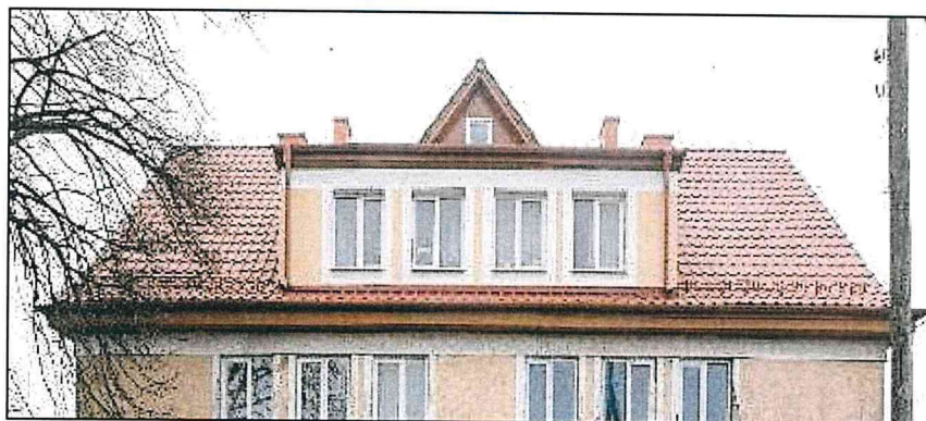
Фото 8. Северо-западный скат крыши.
