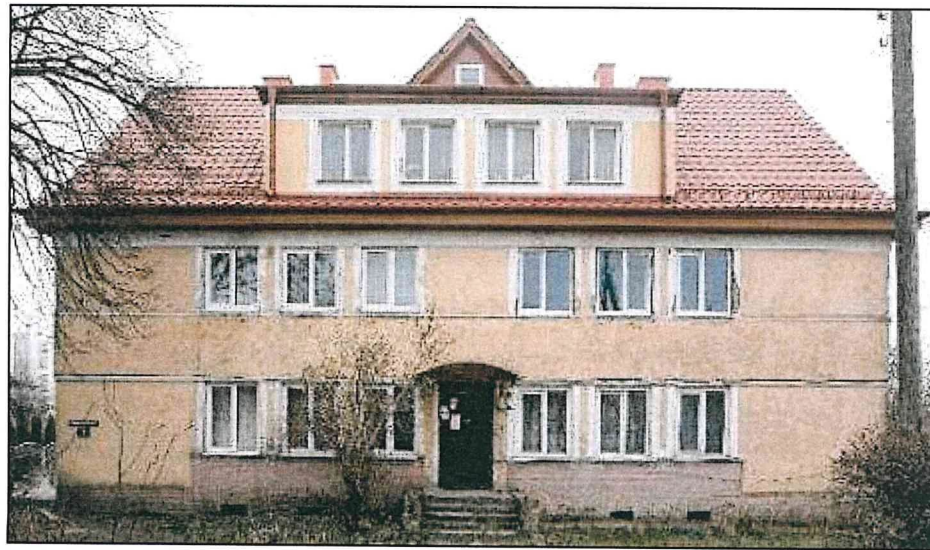
Фото 1. Вид с севера. Главный северо-западный фасад. (фото 2021 г.)
