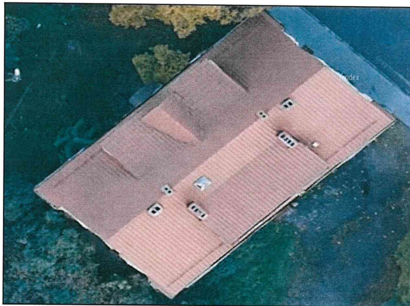
Фото 7. Крыша. Вид сверху.
