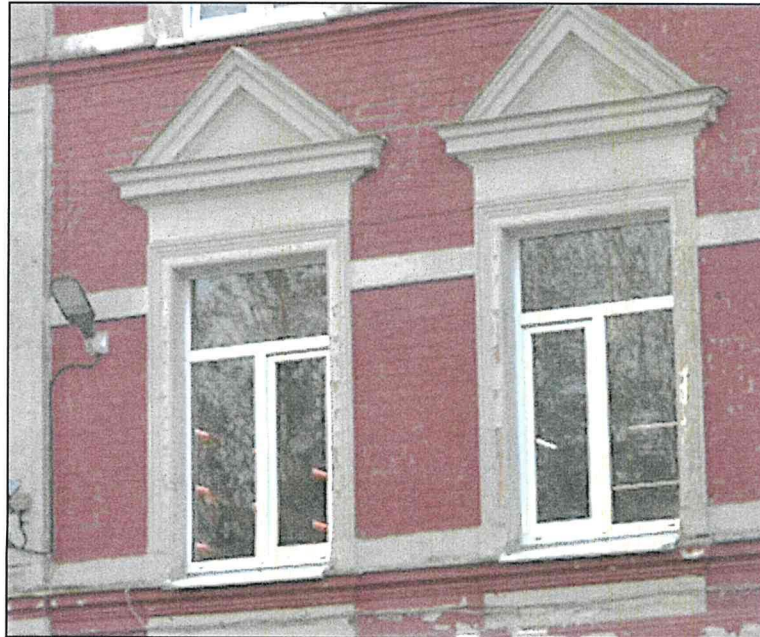
Фронтоны оконных проемов второго этажа на раскреповках
