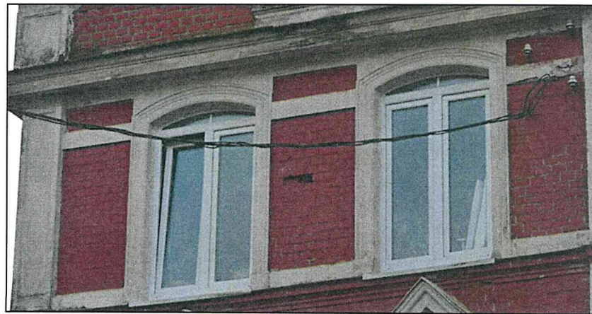
Пояски подоконных карнизов мансардных окон
