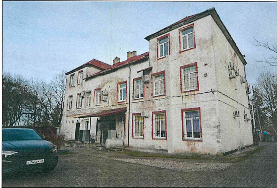
Дворовой (юго-восточный) фасад
