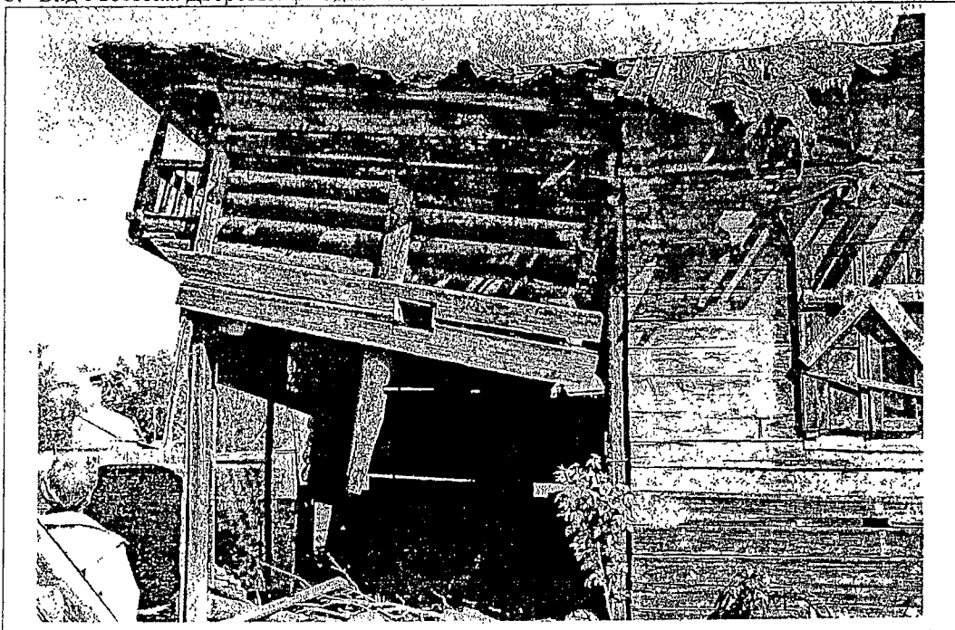
4. Фрагмент бокового северо-западного фасада. Прируб – лит. А. Фото 2006 г.
