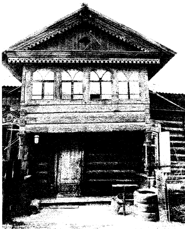
Фото 6 - Юго-западный фасад дома, входной прируб лит. А1
