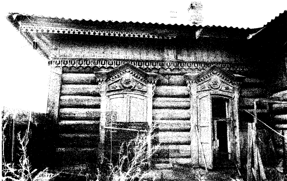
Фото 15 - Фрагмент юго-восточного фасада. Наличники оконных проемов. Фризовый пояс, карниз
