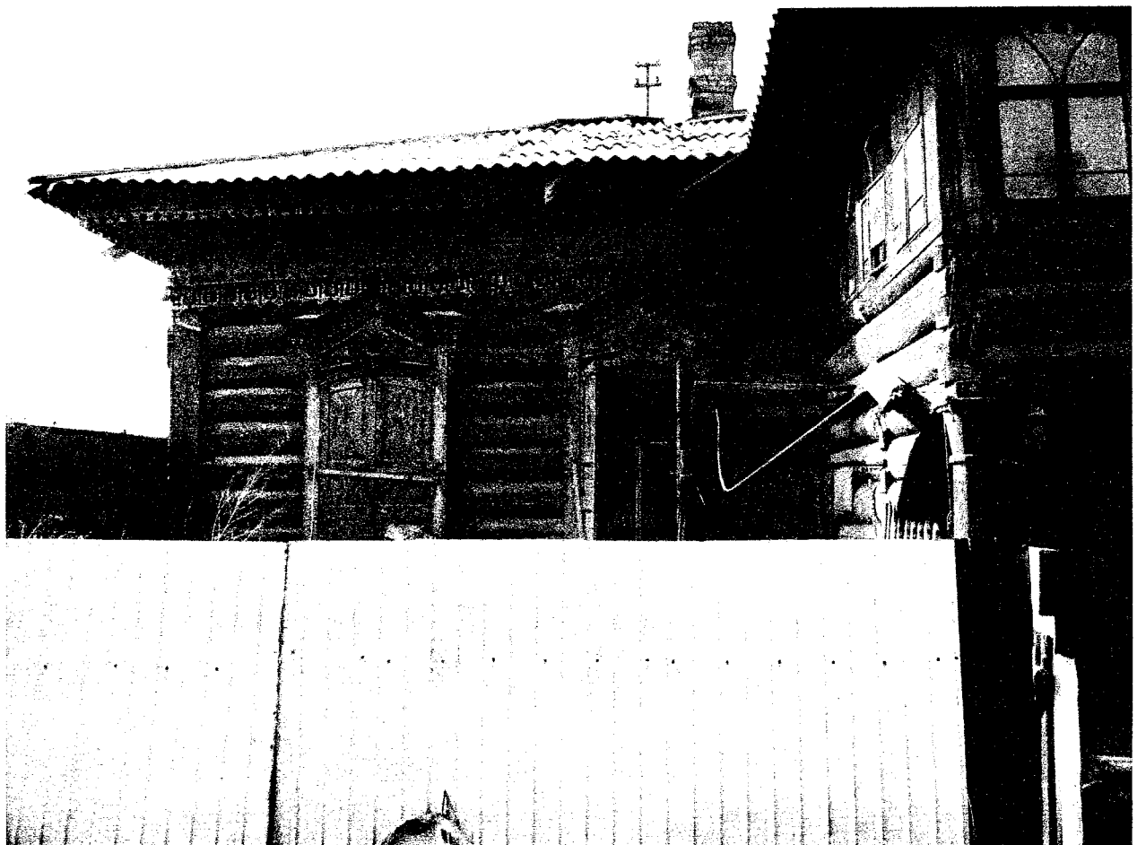
Фото 4 - Фрагмент бокового (юго-восточного) фасада
