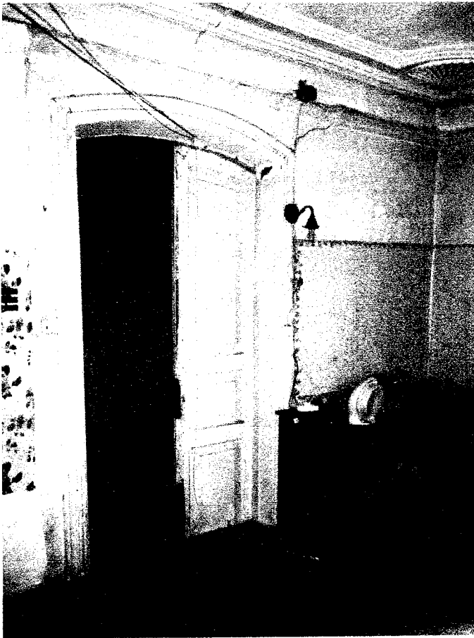
Фото 23 - Распашная филенчатая дверь. (пом. №№5,6)
