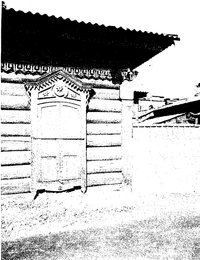
Фото 13 - Фрагмент главного фасада. Наличник оконного проема, лопатка, фриз, карниз
