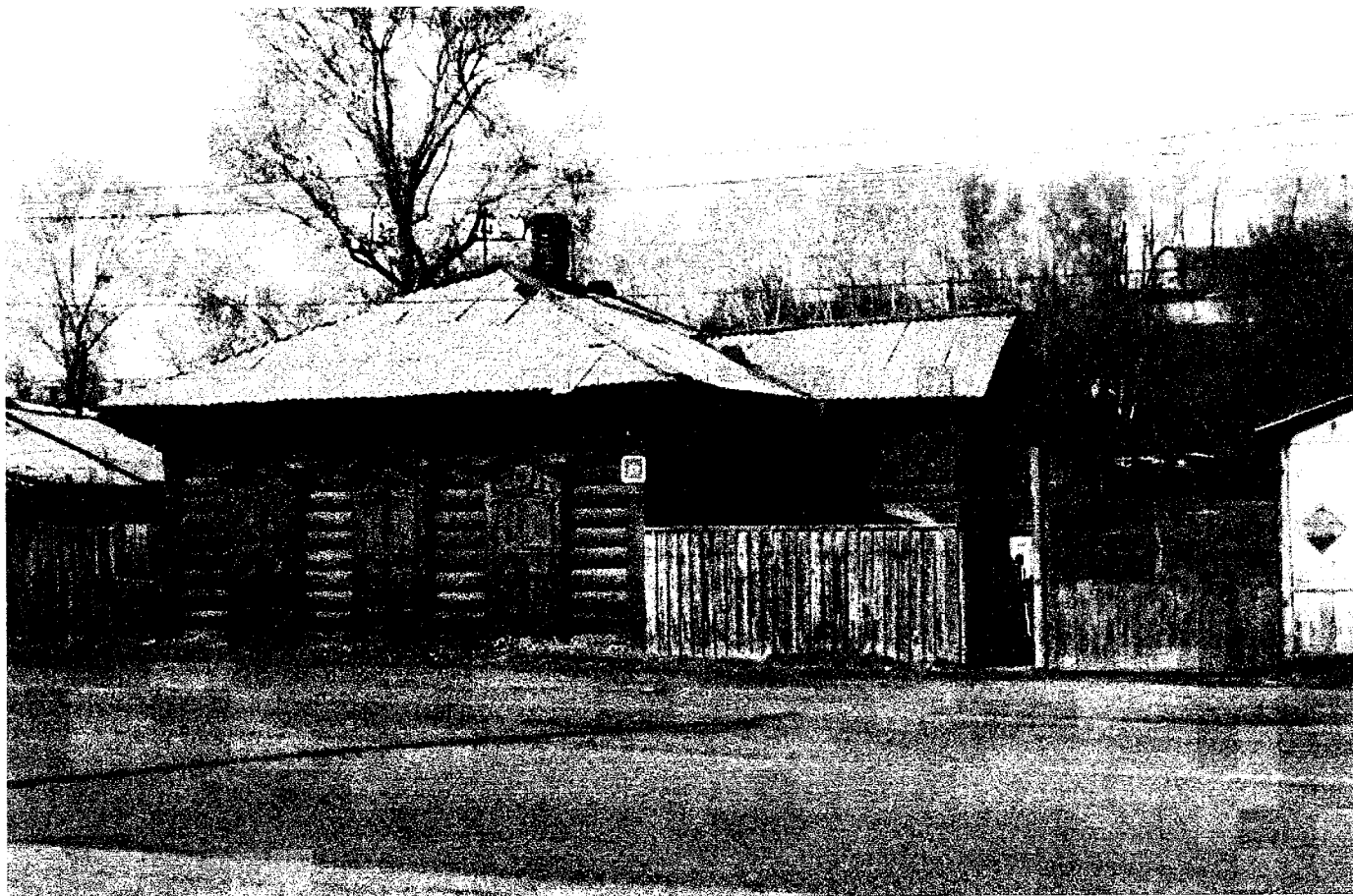
Фото 2 - Главный (юго-западный) фасад дома лит. А
