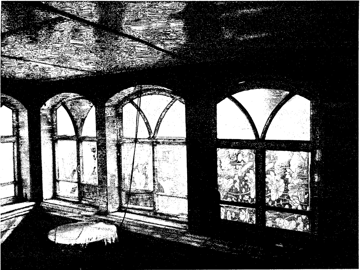
Фото 30 - Оконные проемы галереи 2 этажа. Вид изнутри
