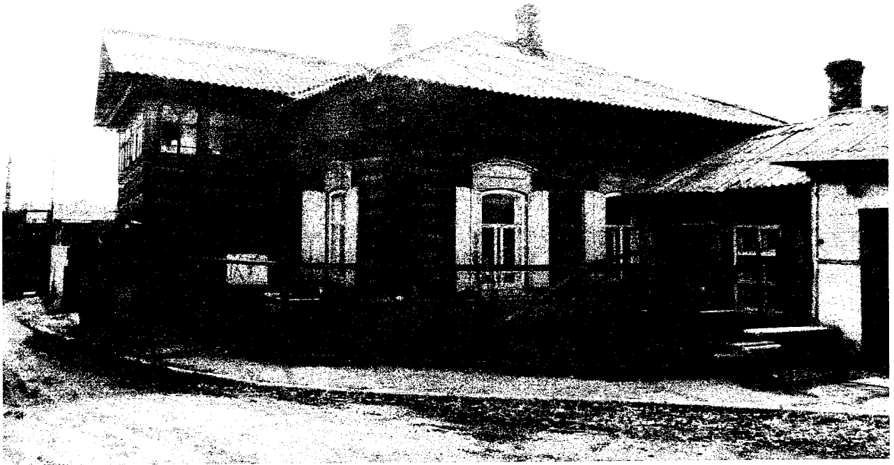
Фото 7 - Вид на здание лит. А с востока. Юго-восточный, северо-восточный фасады дома
