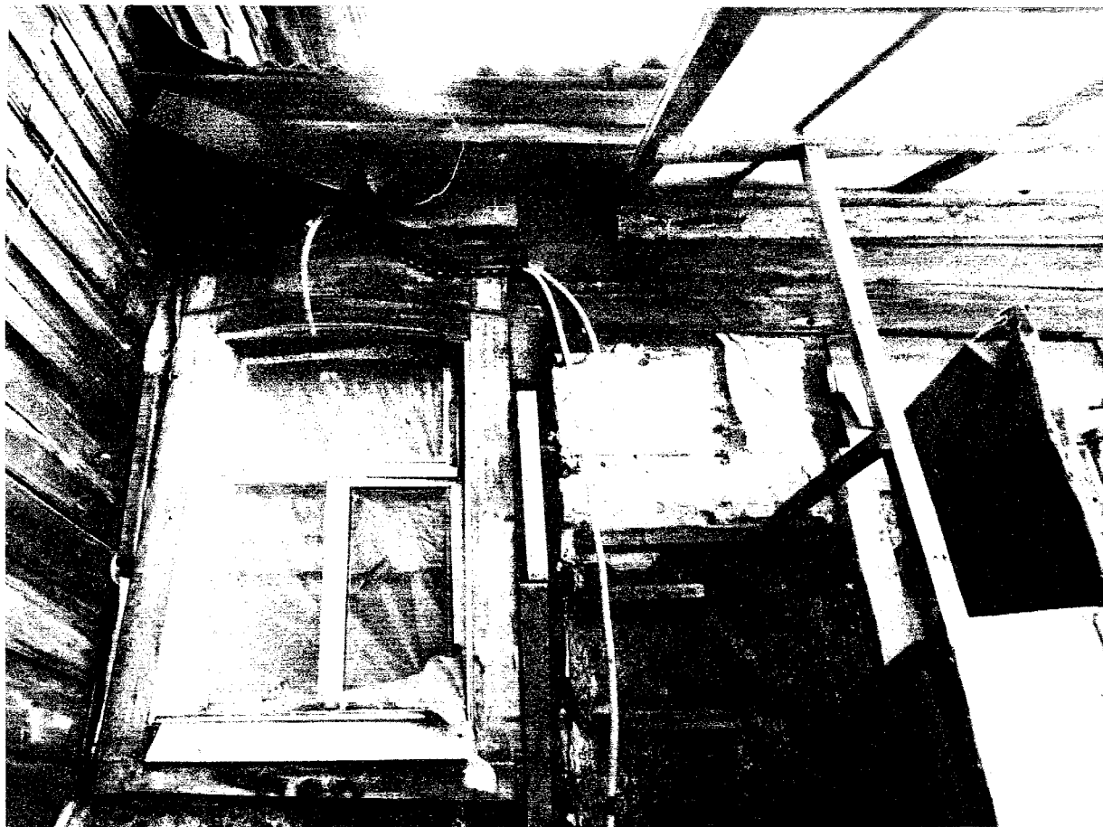
Фото 13 - Боковой юго-западный фасад (лит.А, А1)
