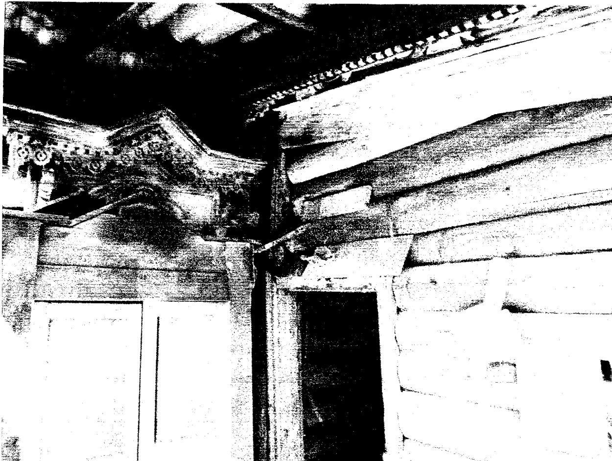
Фото 5 - Фрагмент северо-восточного фасада (прируб сеней)
