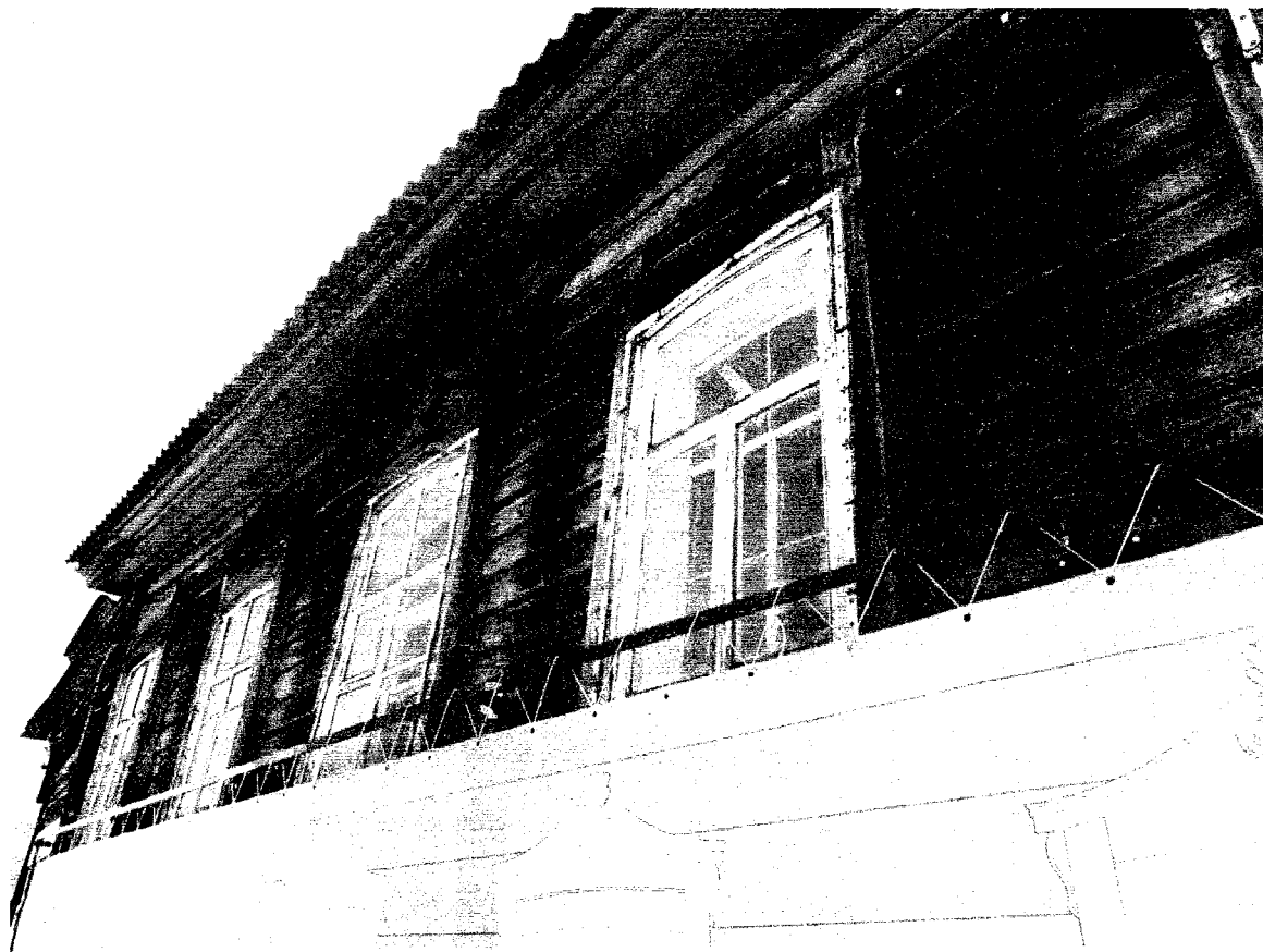
Фото 5 - Фрагмент главного юго-западного фасада (лит. А1)
