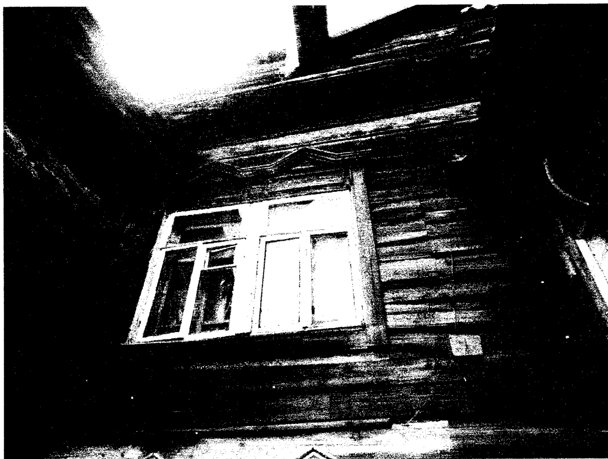
Фото 01 - Фрагмент стены дворового северо-западного фасада (лит.А)
