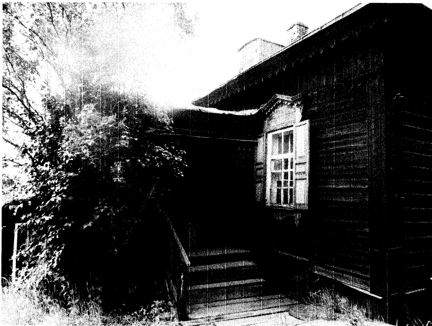
Рис. 10 - Юго-западный фасад здания лит.А по адресу ул. Грязнова, 38
