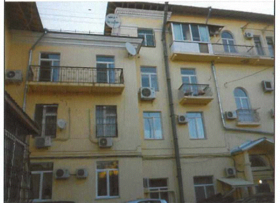
юго-западный (дворовой) фасад
