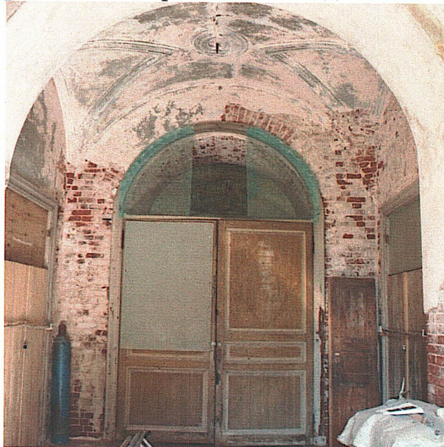
Дверь входа в нижний ярус храма, вид из помещения рундука. Центральная часть паперти с сомкнутым перекрытием соединяется широкой аркой с нижней площадкой рундука
