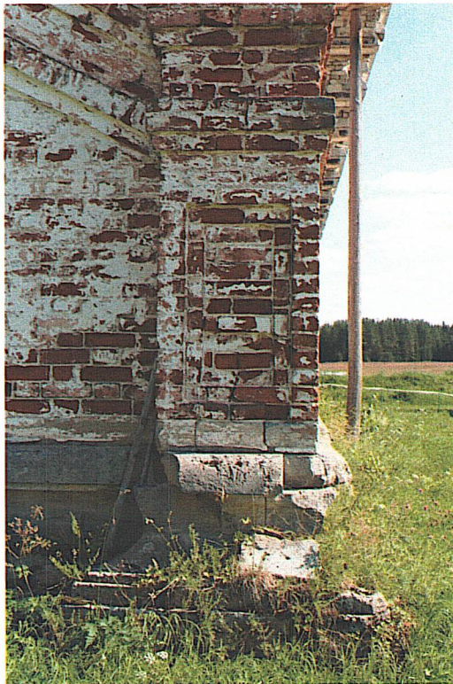
Низ лопатки на юго – западном углу объема лестницы со ступенчатым поясом в средней части
