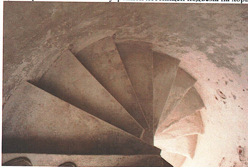
Винтовой марш лестницы подъема на хоры
