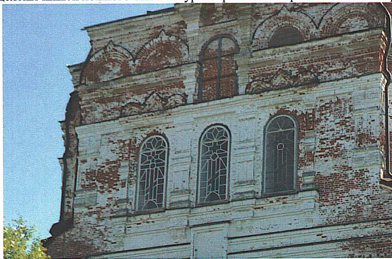
Три арочных окна на северном фасаде восьмерика храма с ажурными решетками; ложное окно на центральной оси фасада; киот в уровне межъярусного карниза
