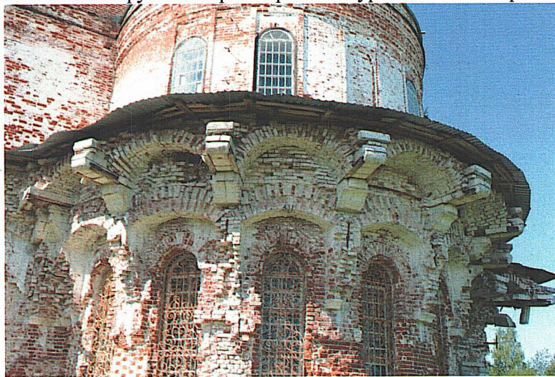
Шесть арочных оконных проемов в нижнем ярусе алтарной апсиды. Четыре окна – в верхнем ярусе, разделены нишей ложного окна. Ажурные решетки в проемах нижнего яруса
