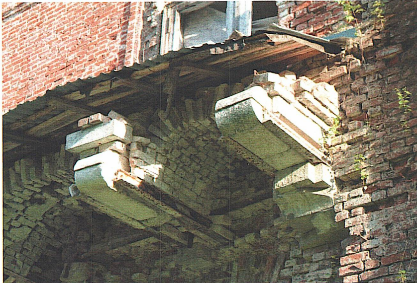
Белокаменные детали в облицовке консолей галереи, арки из кирпича между консолями, консоли выполнены из металлических двутавров. Сверху над галереей устроена консервационная кровля
