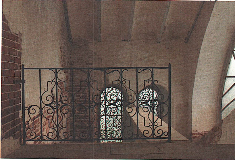
Ограждение верхней площадки рундука, перекрытие над южной лестницей из сводов Монье
