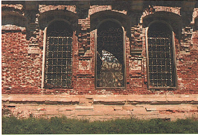
Оконные проемы нижнего яруса четверика храма. Ажурные железные решетки в проемах.
