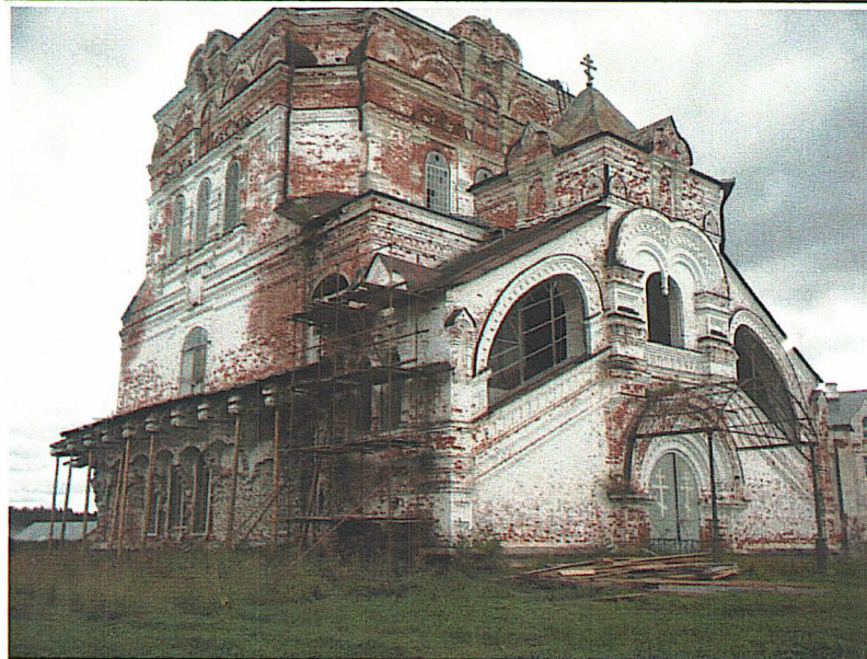
Западный и северный фасады
