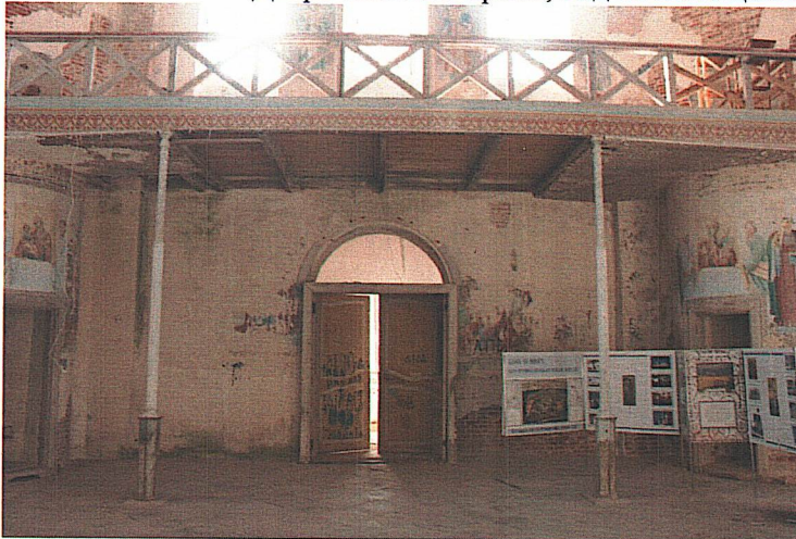
Дверь верхнего храма, вид из помещения храма на западном плане хоры на чугунных стойках
