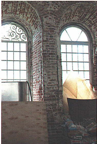
Перемычки оконных проемов в верхнем ярусе храма
