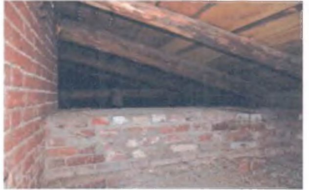
Фрагменты интерьера чердака.
