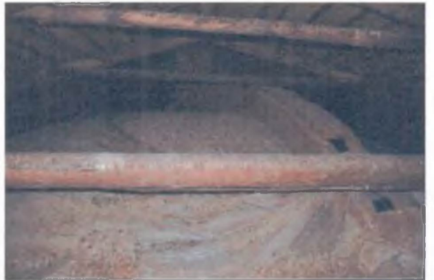
Фрагменты интерьера чердака.
