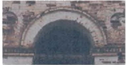
Фрагмент проема звона, западный фасад 2-го яруса колокольни.
