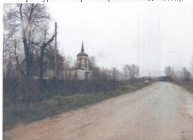
Вид на объект с дороги (вид с северо-запада).
