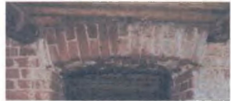
Фрагмент интерьера чердака, дверной проем.
