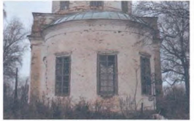
Фрагмент восточного фасада (крыша алтарной апсиды).
