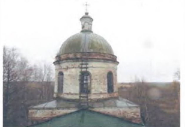
Фрагмент крыши (вид с запада).
