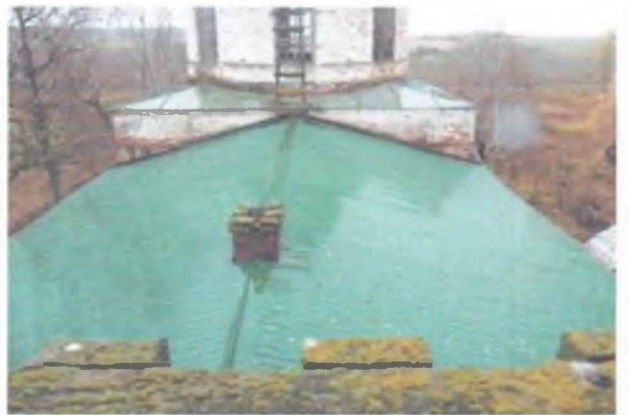
Фрагмент крыши (вид с запада).
