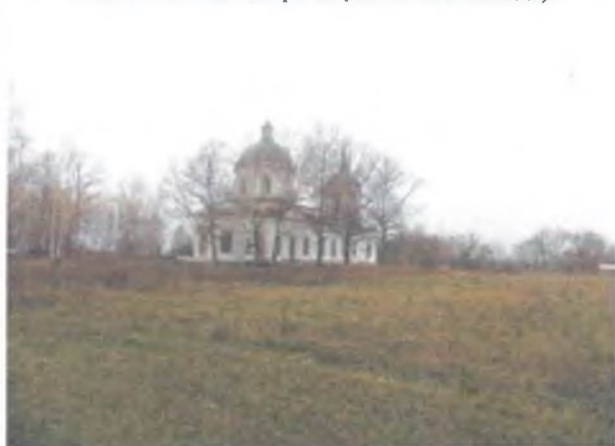
Вид на объект с поля (вид с северо-востока).
