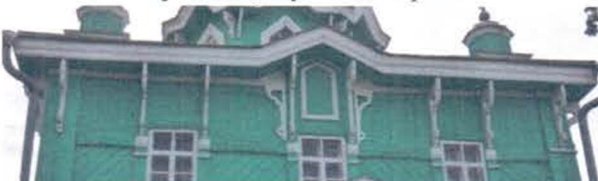
Фрагмент северного фасада, карниз четверика
